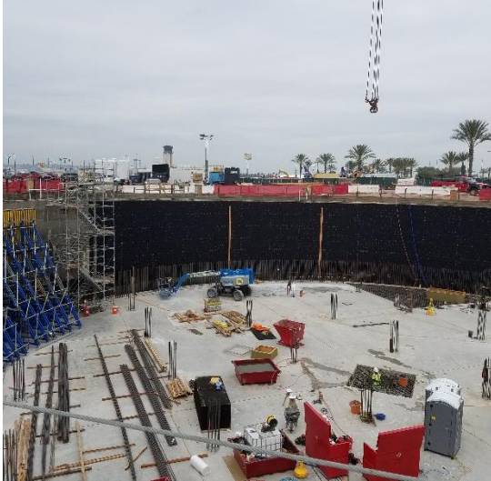
Ready to pour final section of the floor slab
