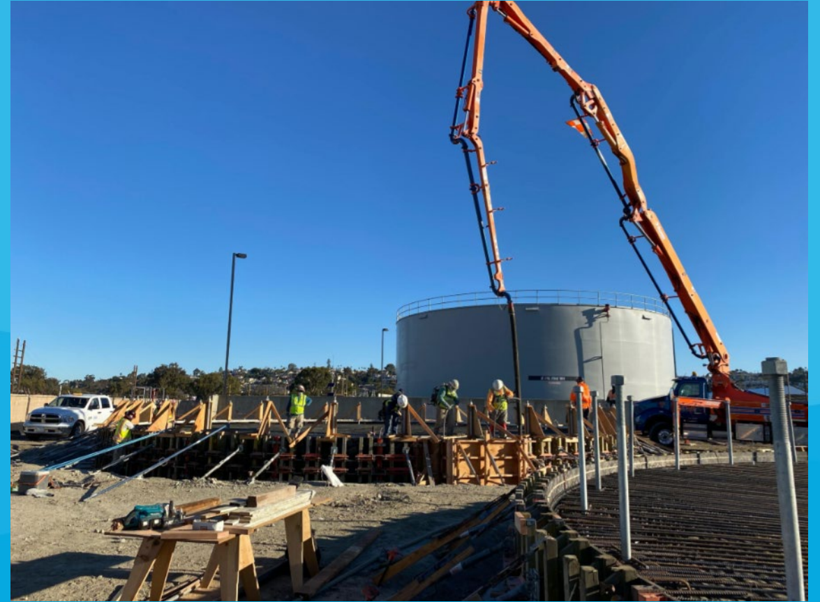
Concrete Pour in Progress
