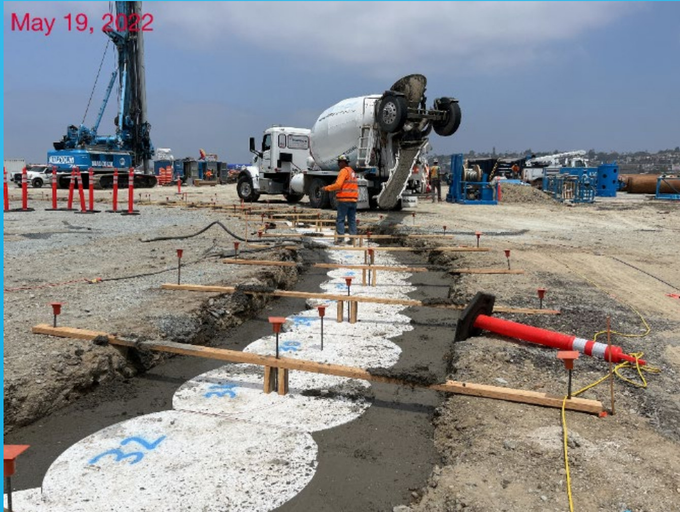
Cistern - Secant Pile Guide Ring
